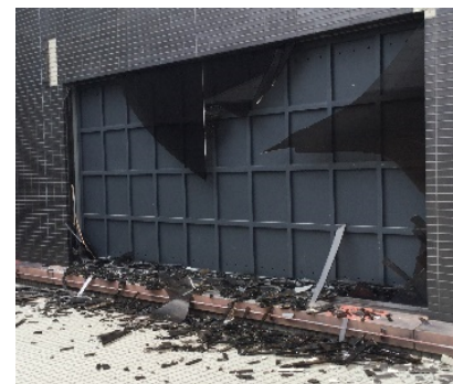
(左図：被災したパティオの大型ガラス、右図：アルミ製にして修繕)
