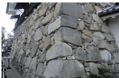
彦根城天守台の石垣 1606年竣工の天守閣の基礎をなす石垣。他の城の石垣から移築されているといわれるが、全てがそうなのか分からない。主に固結度の高い緻密な凝灰岩からなり、チャートや花崗岩も含まれる。戦国武将にとって石垣用石材は重要な戦略物資であった。
